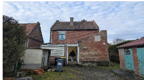
façade de l'existant sur jardin
