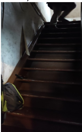
L'escalier d'accès à l'étage
