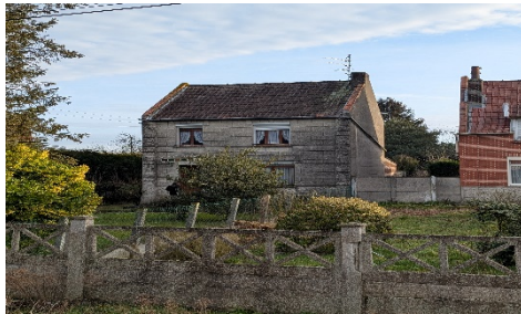
Façade de l'existant sur rue
